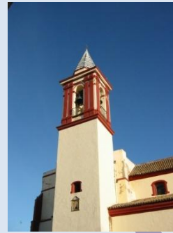
Torre de San Juan
