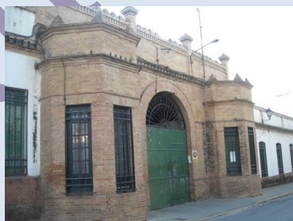
Casa Cuartel de la Guardia Civil
